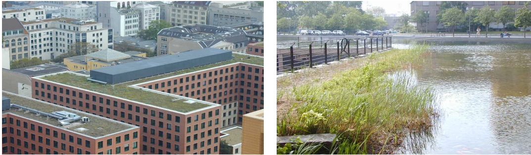
(그림 16) 베를린 포츠다머 플라츠의 옥상녹화와 빗물을 이용한 도심 인공호소
