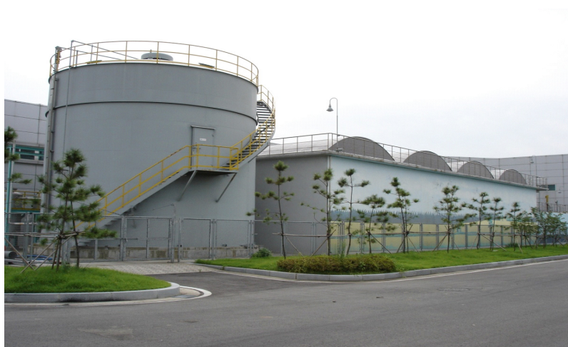
(그림 12) 음식물 처리시설 사례(인천송도자원화센터) 9)
